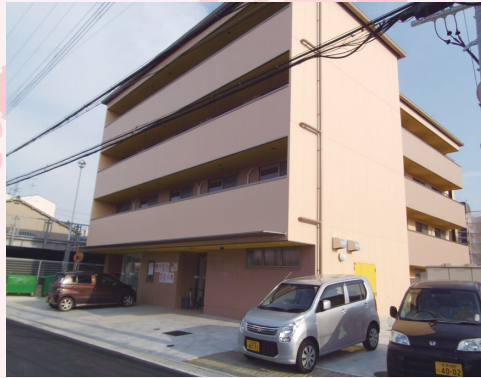
サービス付き高齢者向け住宅 ファミリーモア八重桜 門真館
